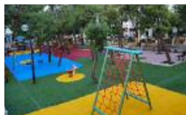
Πλήρης ανακαίνιση στην παιδική χαρά της οδού Αναστάσεως
